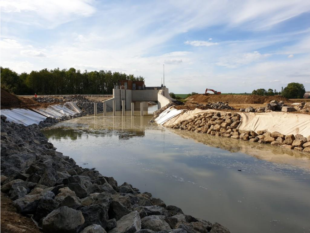
Figure 7 : Photo du dispositif anti embâcles sur le site de Montigny sous Marle, phase travaux (Aisne)
